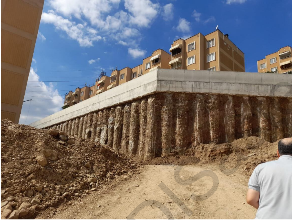
Şekil 3.20. Yeni inşa edilen istinat duvarı.
