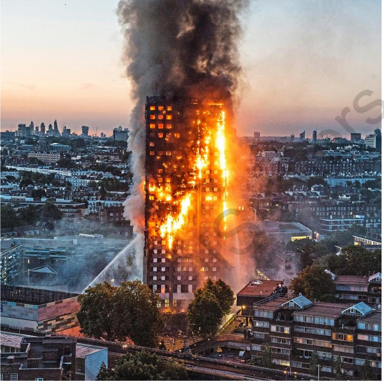
Şekil 5.46. Grenfell Tower binasında yangın
